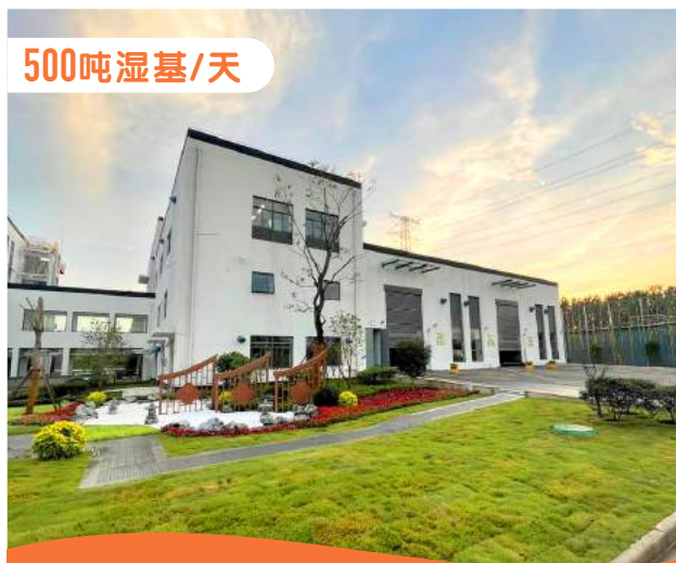
扬州污泥干化处置项目
